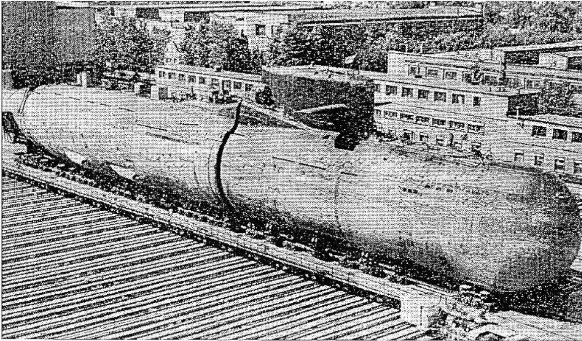
Ein ausgemustertes Atom-U-Boot in der Swesdotschka-Werft in Sewerodwinsk. In der Mitte ist die Lücke sichtbar, die durch das Herausschneiden des Reaktor-Segments entstanden ist. (Werkbild)
