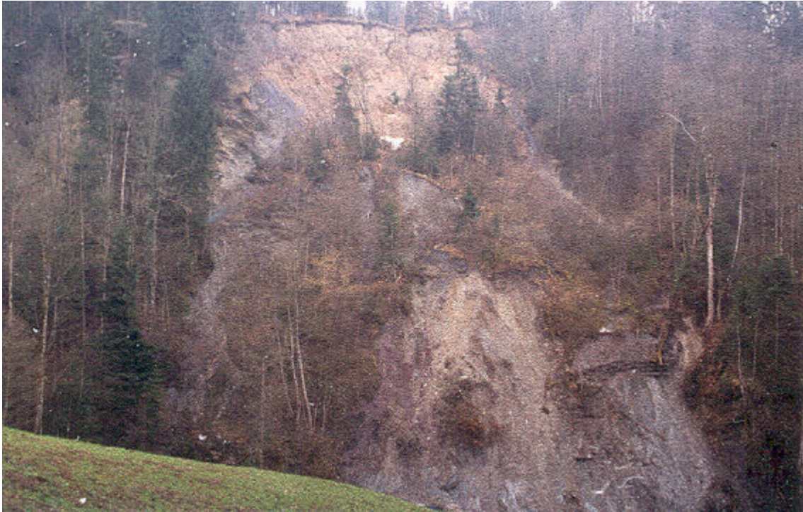
Abb. 4: Die Rutschung im Höllgraben im März 2000. Deutlich sind die Kriechbewegungen im liegenden Haselgebirge und die Felsstürze aus dem hangenden Dolomit zu sehen.
